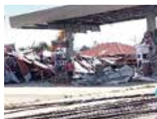
台風被害の様子
